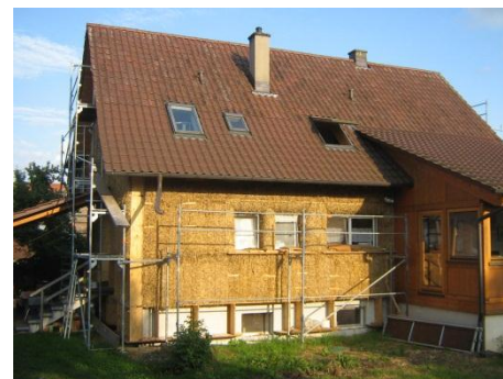
Abb.4 Außendämmung mit Strohballen 2002
