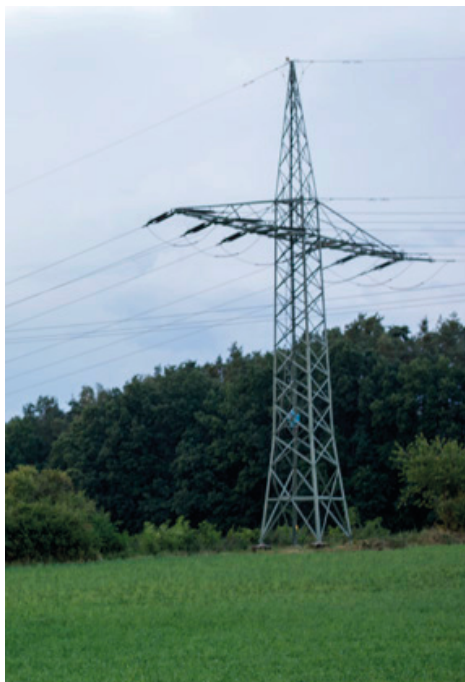
Das Grundstück liegt zu nahe an der Stromleitung
