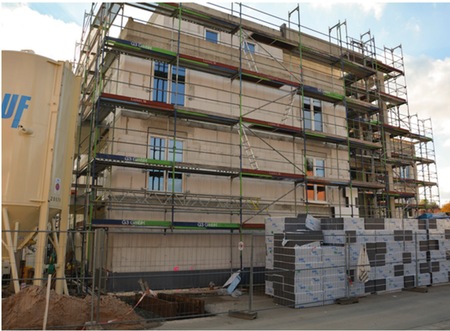
Dieser Rohbau soll ein Wärmedämmverbundsystem erhalten
